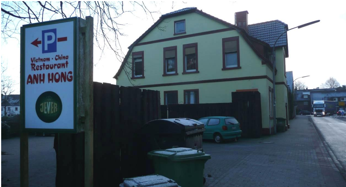
Charlottenburger Ring 41, ehemaliges Wohnhaus, derzeit Übergangsnutzung Bordell
