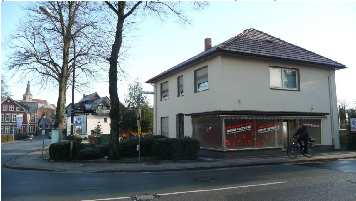
Wohn- und Geschäftshaus Münsterstr. 9, Vordergrund Bielefelder Straße, links Münsterstraße
