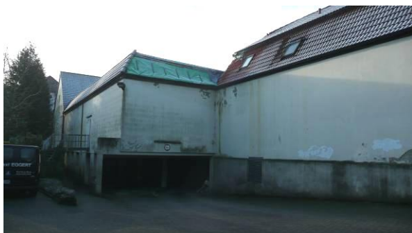
Ansicht vom Parkplatz, Zufahrt Tiefgarage
